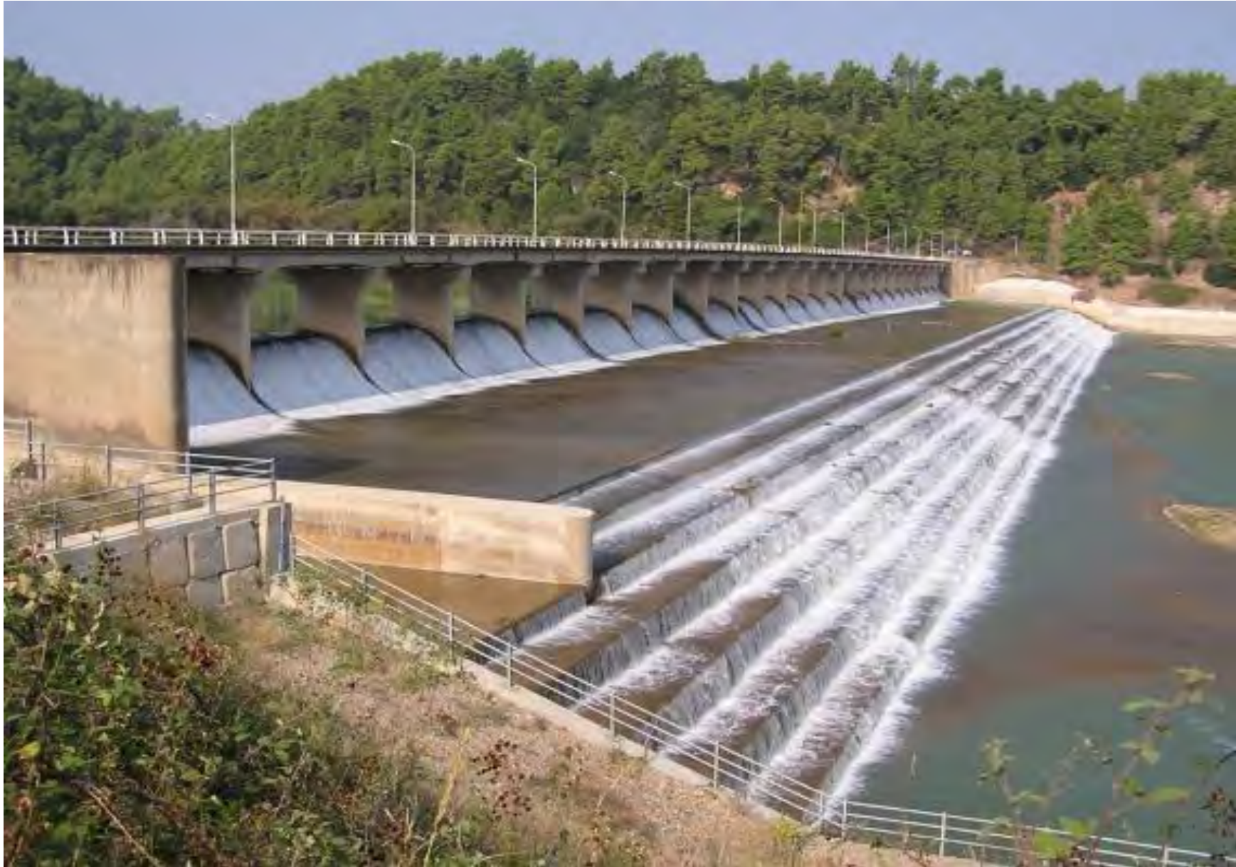
Άποψη του υφιστάμενου αρδευτικού φράγματος στον Αλφειό ποταμό
