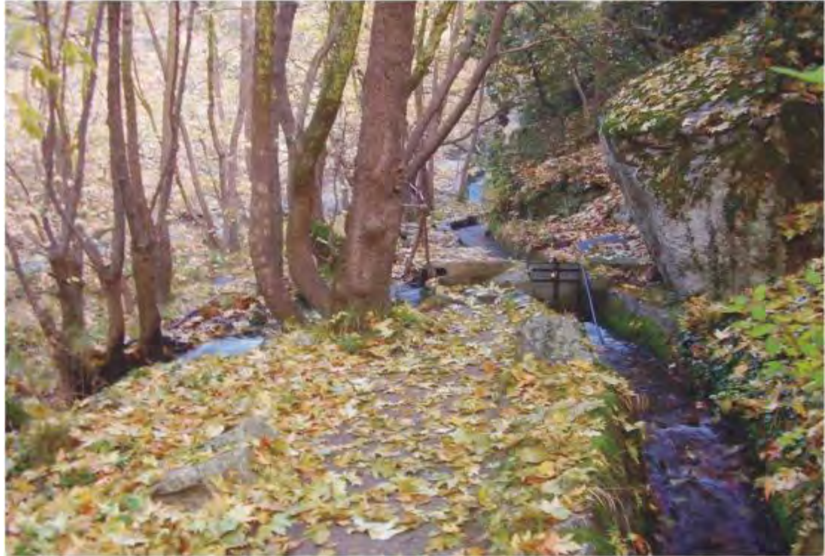
Θέση υδροληψίας αρδευτικού δικτύου και αρχή αρδευτικού αύλακα.
